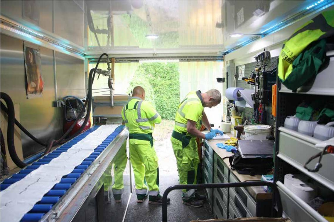
In der mit Heizung, Kalibrier- und SPS-Mischsystem ausgerüsteten mobilen Tränkfabrik wird der Liner auf die erforderliche Länge gebracht, mit Harz gefüllt und unter Vakuum getränkt.
