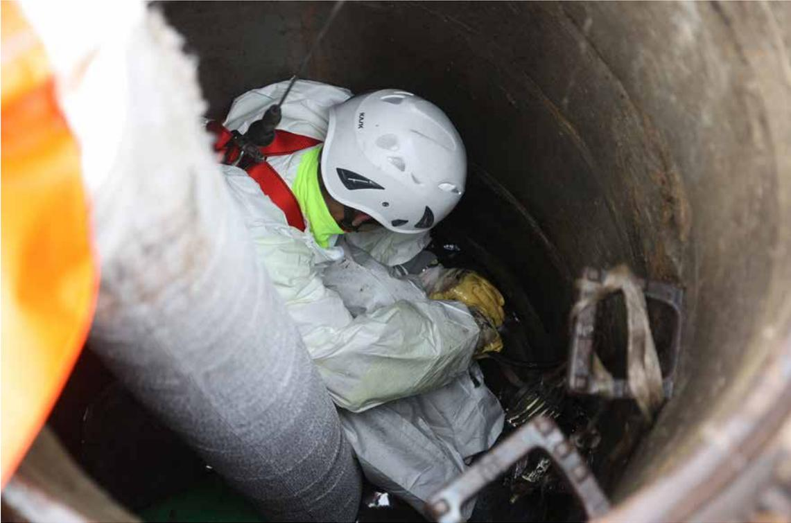
Der Schlauch wird mittels Wasser in den Kanal invertiert und im Anschluss unter Zufuhr von Wärme kontrolliert ausgehärtet.
